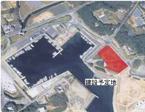
「赤羽根道の駅」の建設予定地(赤羽根港付近)
