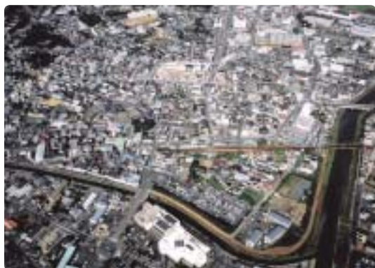
中心市街地の活性化に向けて田原駅周辺を整備
