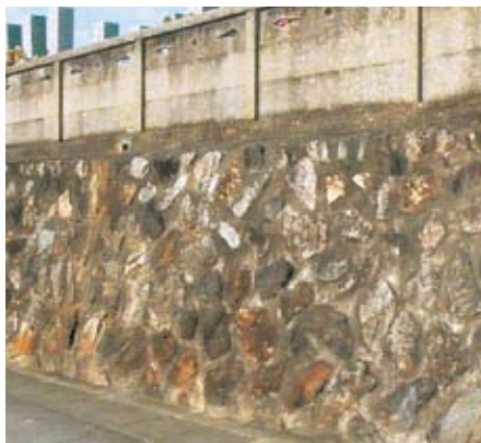
▲波瀬町の人造石遺構(願照寺)
