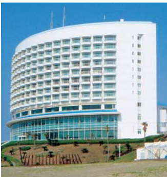
▲津波避難ビルの一つ。観光客の避難施設としても活用されます。(伊良湖シーパーク&スパ)
