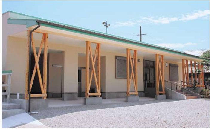
▲完成した野田南集会所
