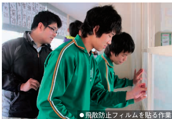
●飛散防止フィルムを貼る作業
