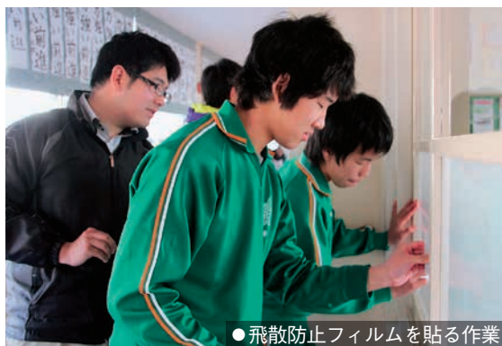
●飛散防止フィルムを貼る作業
